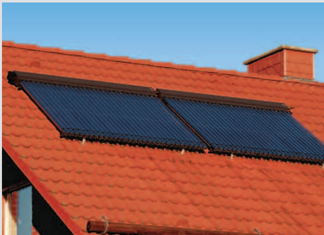
Colector de tubos de vacío según el principio Heatpipe
